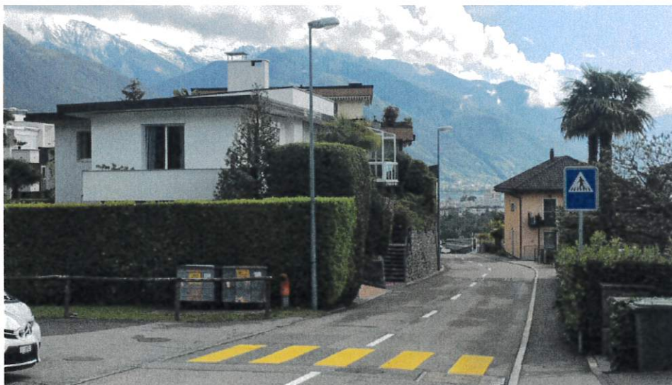
Passaggio pedonale oggetto di verifica
