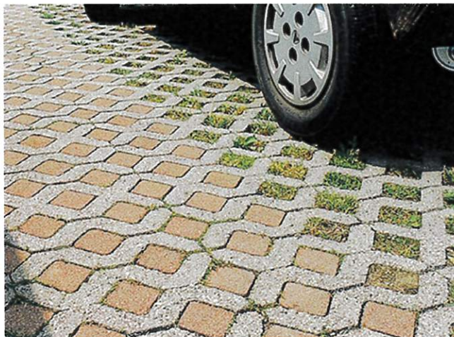
Esempio di impiego di grigliati erbosi
