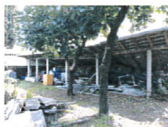
Area degradata da ripristinare
