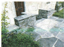
Muri e pavimentazioni da riconsiderare
