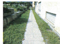
Blocco cucina e muro da demolire
