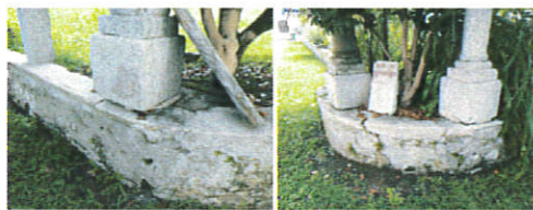
Colonne e muri storici da ripristinare
