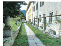
Viale nord vista E-O
