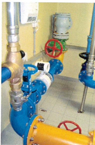
Elementi da sostituire parzialmente (passaggi murali e vecchie saracinesche).
