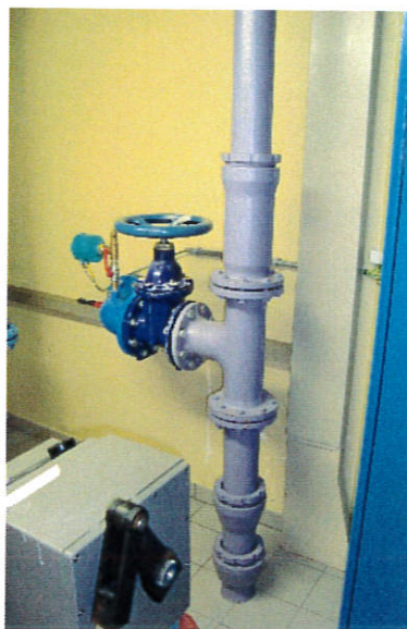
Elementi da sostituire parzialmente (passaggi murali e vecchie saracinesche).
