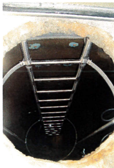
Accesso attuale al serbatoio dalla soletta di copertura.
