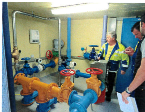
Elementi da sostituire parzialmente (passaggi murali e vecchie saracinesche).
