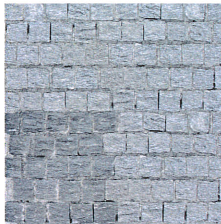
Ascona, comparto Piazzale Torre, campione pavimentazione.
