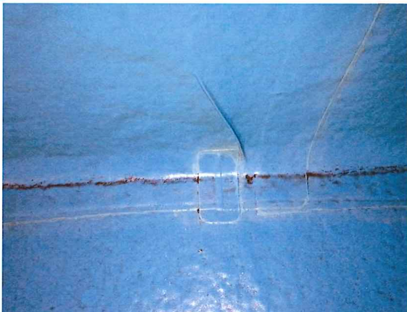
Figura 7: Riparazioni della plastica sarnafil
