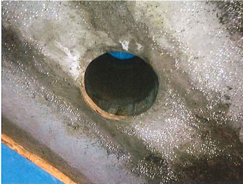
Figura 5: Interno della botola
